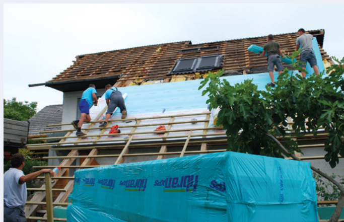
2. Na zgornji strani strehe ohranimo obstoječo volneno toplotno izolacijo med špirovci in nanje položimo FIBRANxps MAESTRO izolacijske plošče.
