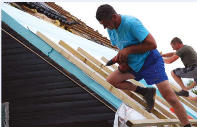
3. Namestimo in pričvrstimo reflektivno paroprepustno membrano in preko vzdolžne letve vse našete sloje pričvrstimo v špirovce.
