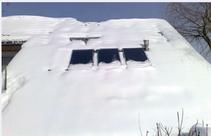
1. Taljenje snega na strehi nazorno kaže na velike toplotne izgube skozi streho. Zato je sanacija več kot na mestu.
