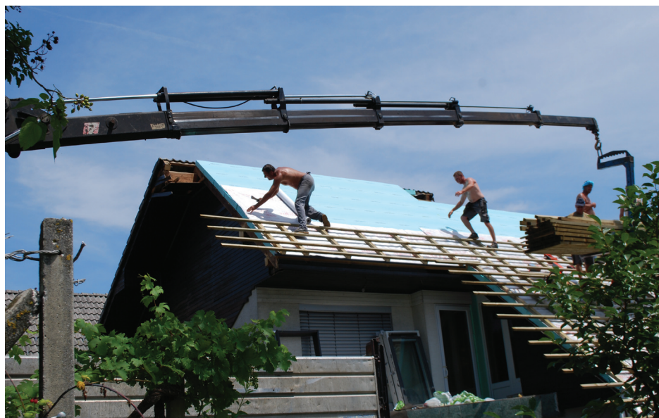
Nameščanje izolacije MAESTRO in reflektivne pomožne kritine.
