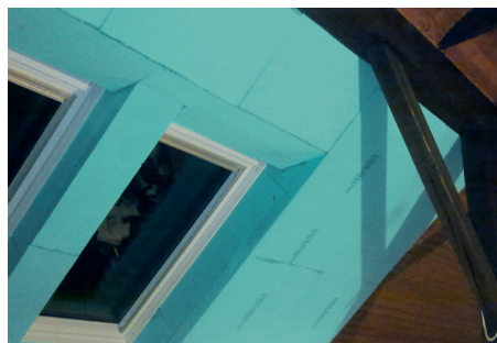
Primer izoliranega ostrešja z dodatno zunanjo in notranjo izolacijo. Notranja izolacija FIBRANxps ETICS GF je istočasno podlaga za notranji "fasadni omet".
